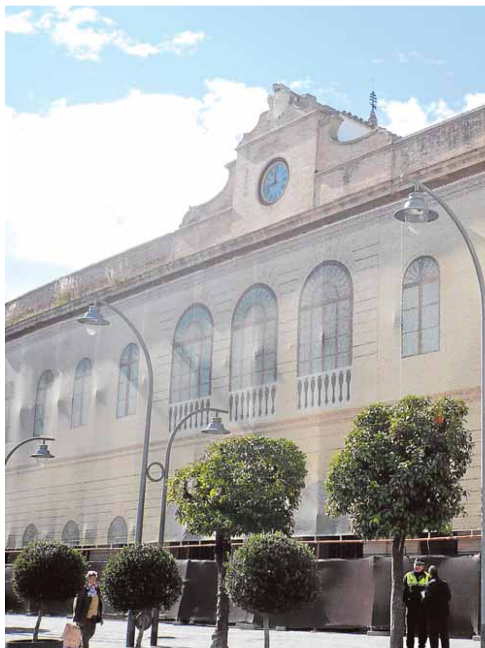
La lona que cubre actualmente el Ayuntamiento tapa un inmueble demolido para s
